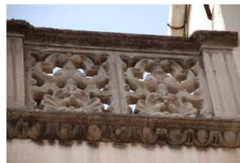
Balustrada d'una balconada de na Camel·la.
