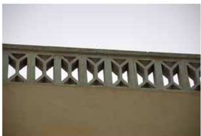
Gelosia de formigó.
