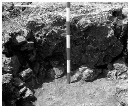
Fig. 2. Cala a l'interior del mur oest.
