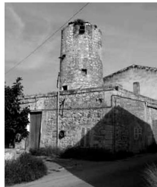
Fig. 3 Estat inicial en el moment de començar la intervenció.
