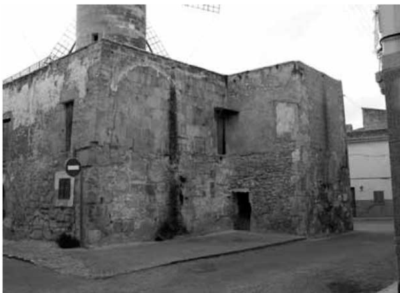
Fig. 1 Estat inicial en el moment de començar la intervenció.
